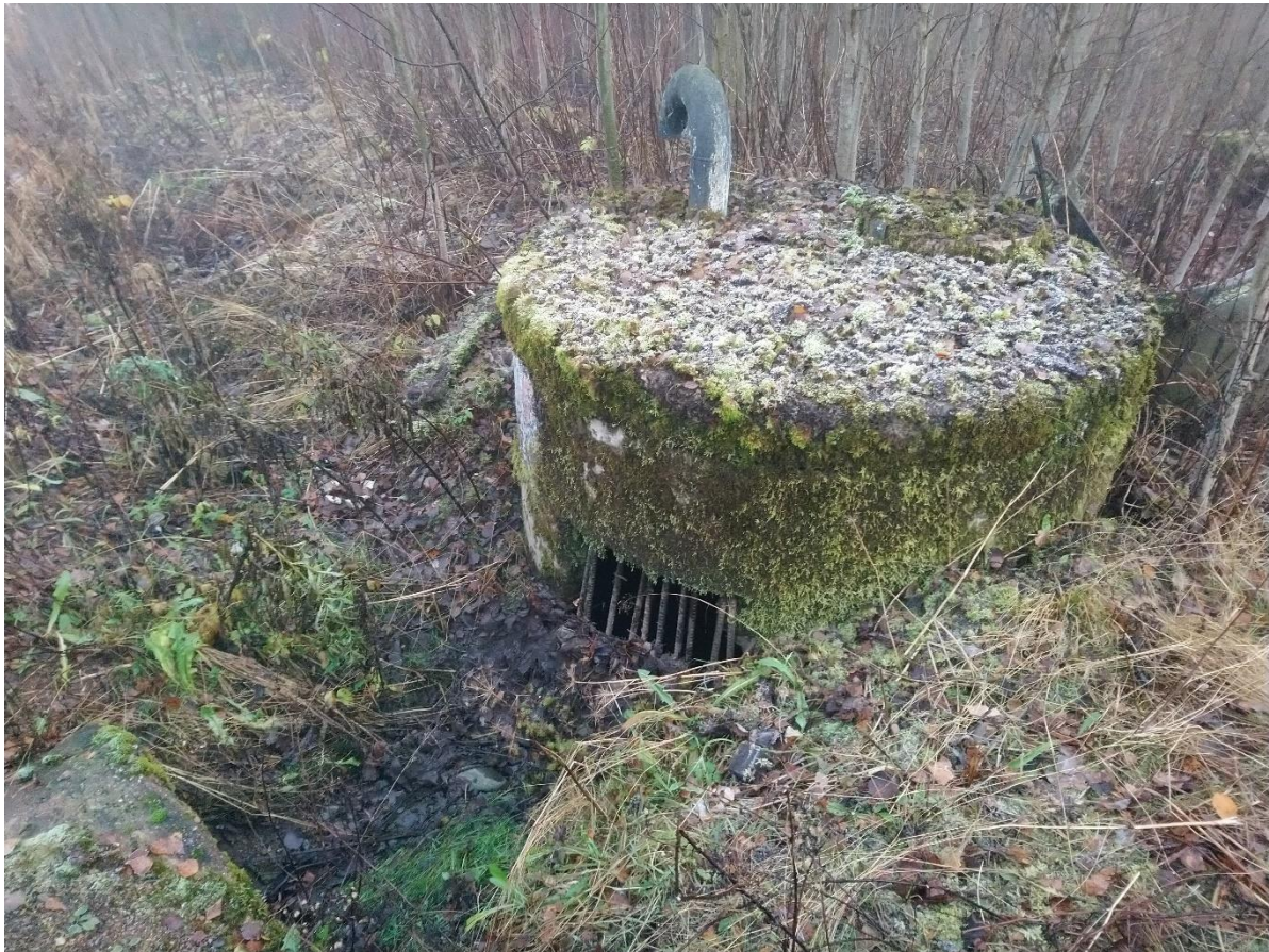
Kuva 2.2. Pääradan alittava rumpu ja sisäänotto kaivoon suunnittelalueen länsiosassa.
